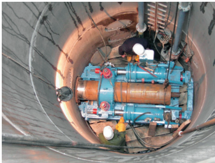
Abb. 5 Blick auf das Horizontalbohrgerät beim Vortrieb
