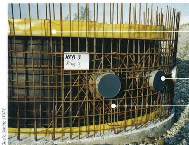
Abb. 4 Verstärkte Schachtarmierung mit den eingesetzten F-Stücken für die Vortriebe
