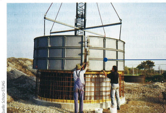
Abb. 3 Montage der Außenschalung während des Schachtbaus
