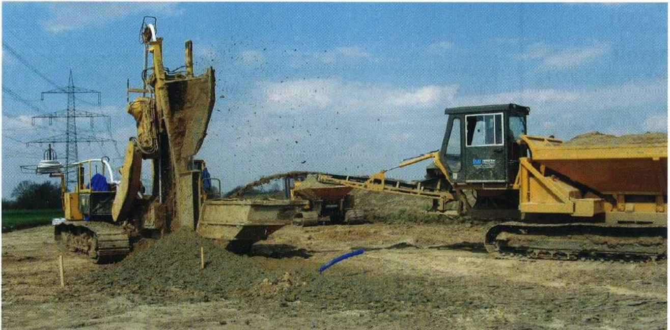
Abb. 8: Dränfräse mit Kiesschütter im Einsatz
